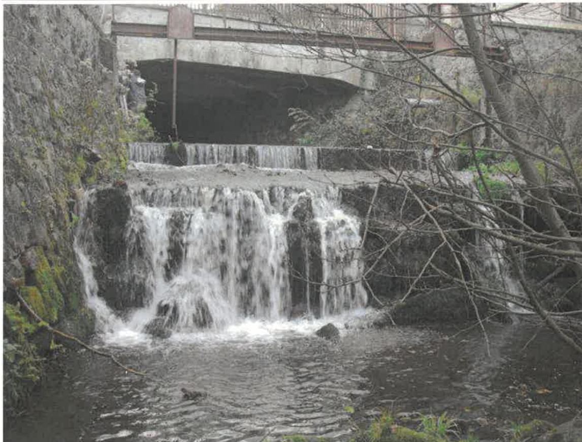
Figure 2 : Photographie de l'ouvrage seuil en rivière
