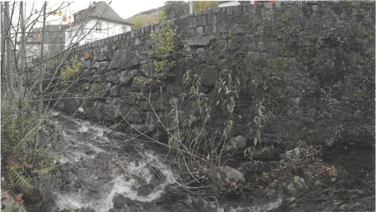
Figure 5 : Vue du mur rive droite en amont du pont
